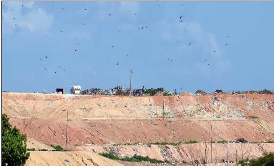
Figura 58 - Exemplo de aterro controlado.
