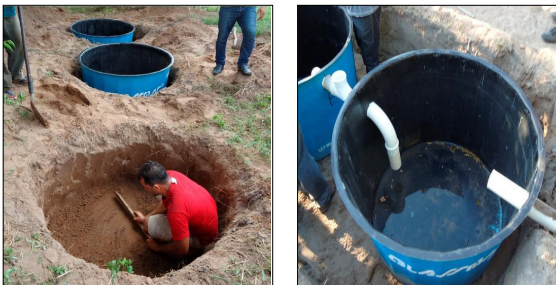
Figura 81 - Exemplo de instalação da fossa biodigestor.
