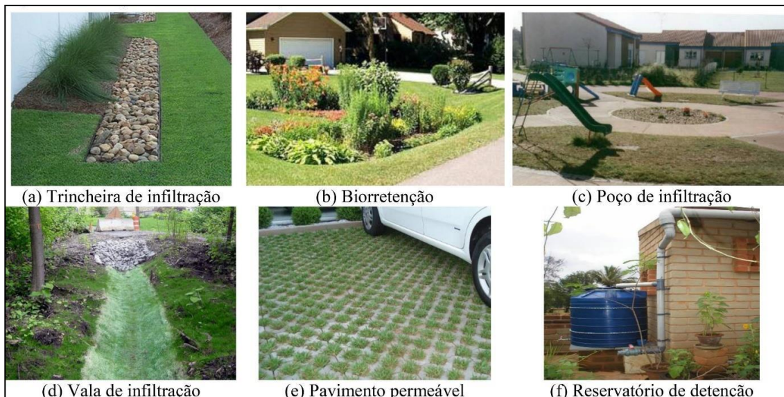
Figura 126 - Exemplos de Controles na Fonte.
