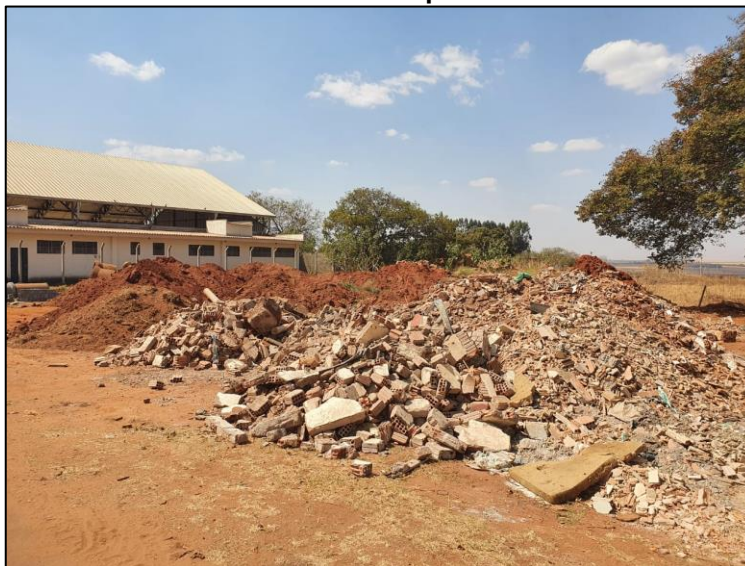
Figura 43 - Local utilizado pela Prefeitura para a triagem de RCC reutilizado em vias da zona rural de Campo Florido.
